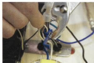
Placer le côté ouvert d'un connecteur d'épissure sur l'un des fils du cordon d'alimentation. Insérer un fil de ventilateur dans le côté fermé. Utiliser des pinces pour enfoncer les épissures dans les fils jusqu'à ce qu'ils soient alignés
